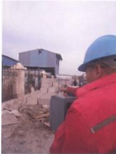
附图 3: 现场检测照片
