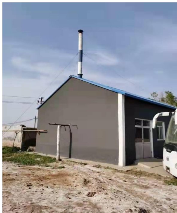
1t/h 天然蒸汽锅炉排气筒
