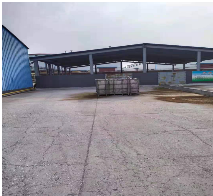
一般固废暂存场所
