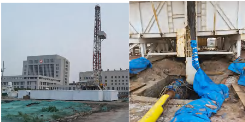
图 3.6-2 施工期现场照片
