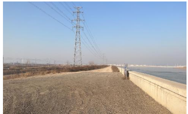
图 2-6 混凝土路面尚未铺设
