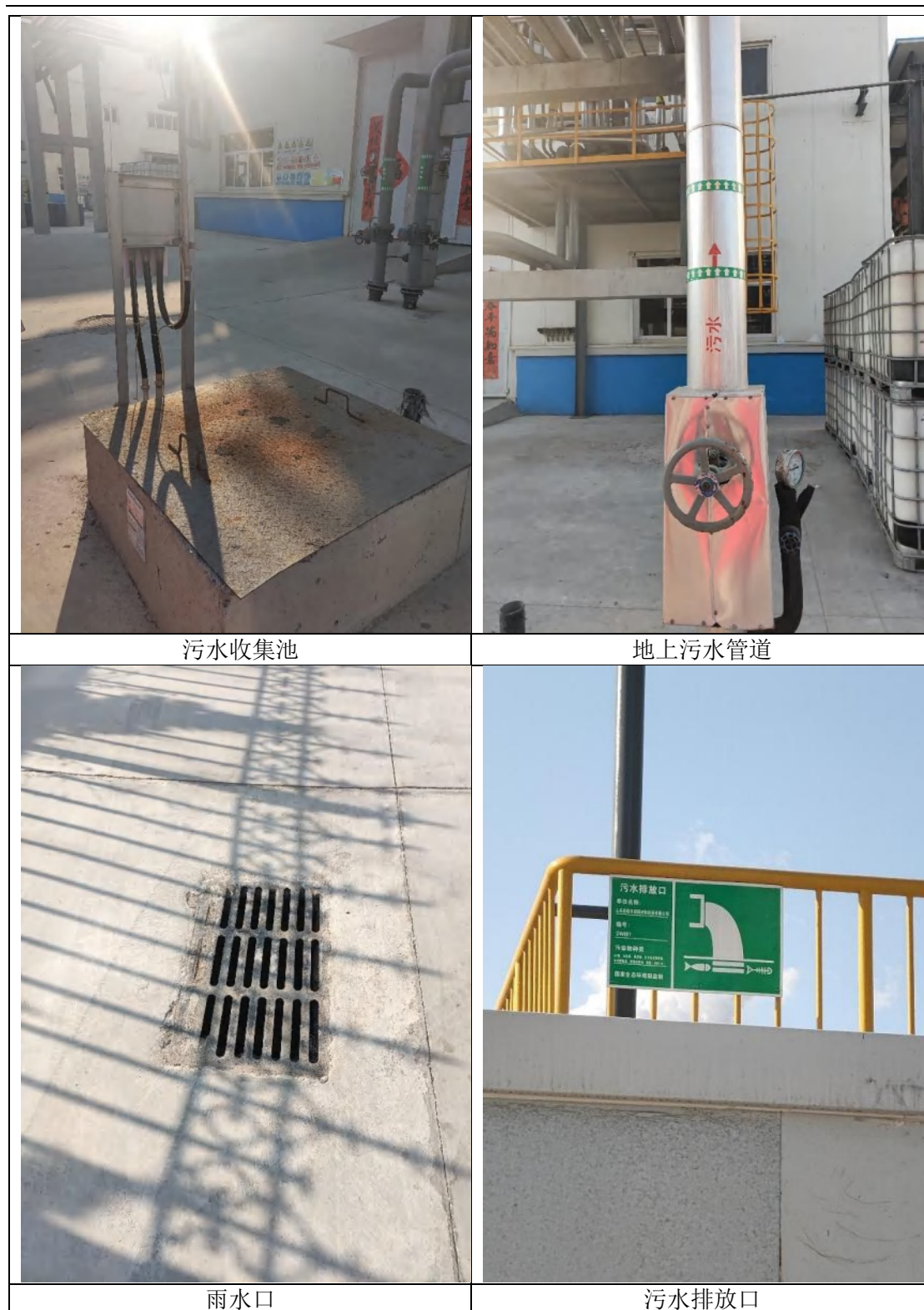
图 4.1-1 厂区污水处理站相关建设图
