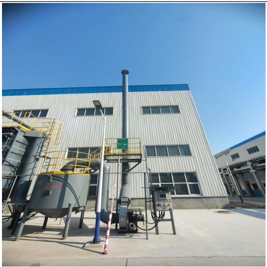
DA003 采样平台及采样口标志
