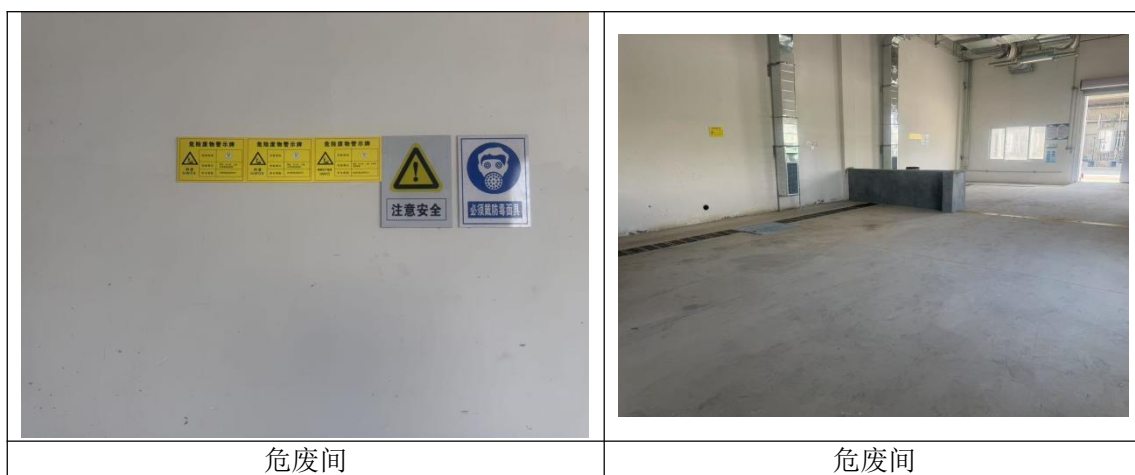
图 3-5 项目现场建设现状情况图
