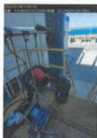
危废间排气筒出口
