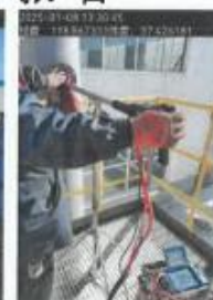
微纳米材料车间排气筒出口
