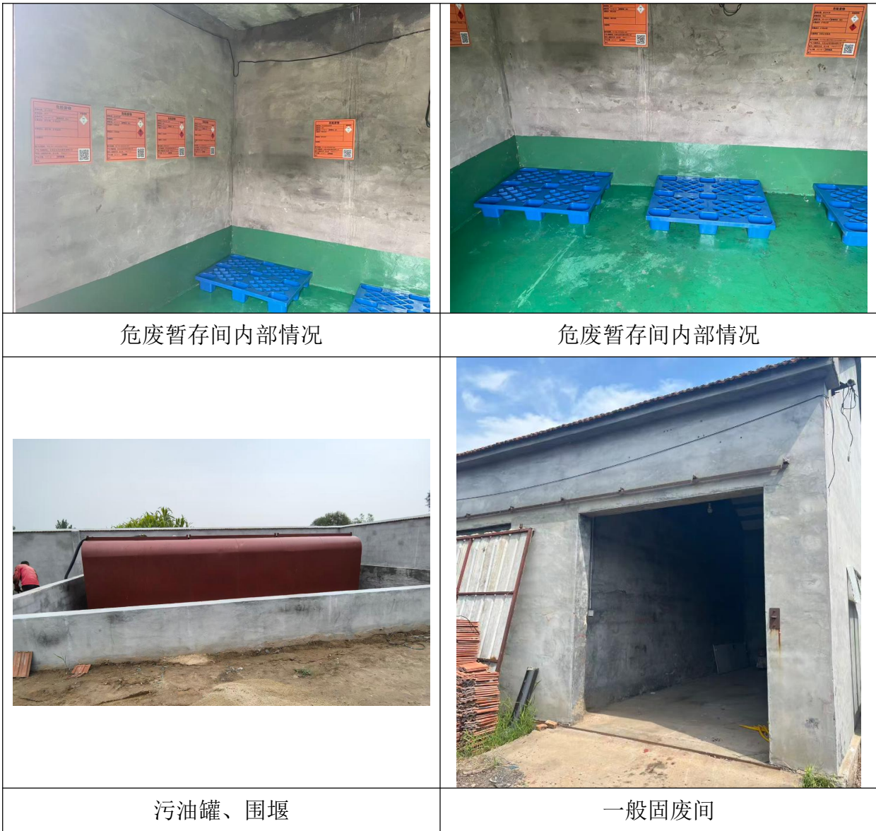
图 4.1-4 固废废物收集措施
