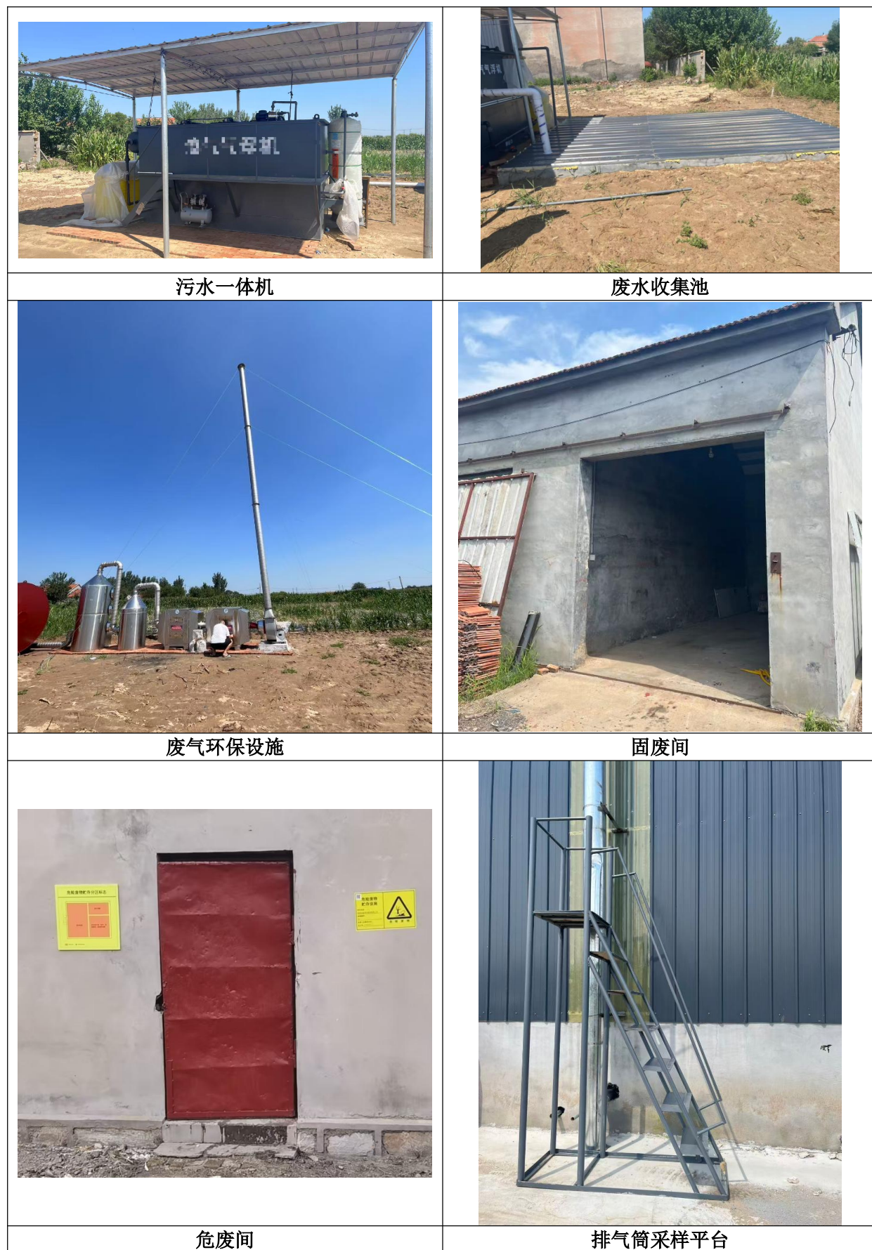
图 3.2-1 本项目建设现状情况
