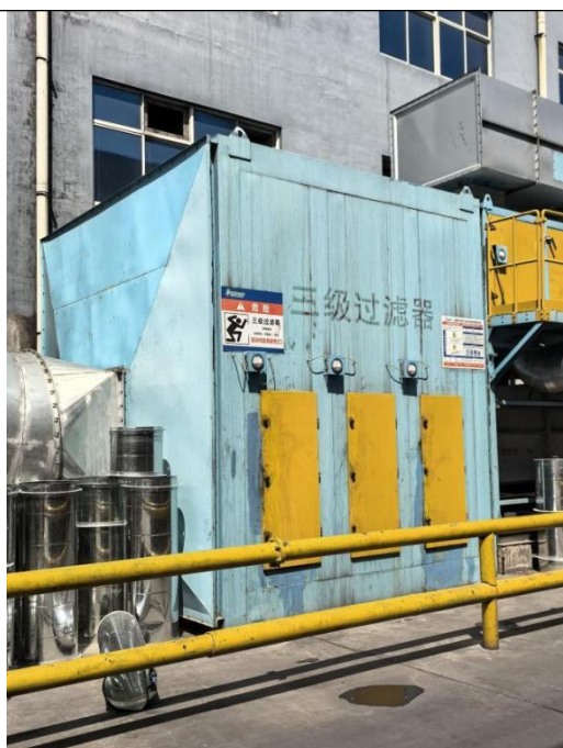
密炼废气三级过滤器
