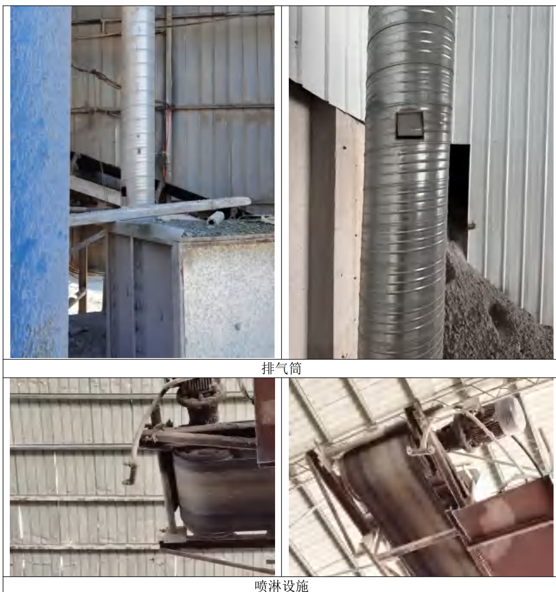
图 4-1 项目废气处理设施图
